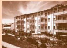
20. Seniorenstift Falkenhöh Betriebs GmbH, Falkensee
